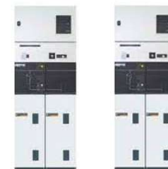
URZĄDZENIE WYKONAWCZE (UW PWP)
