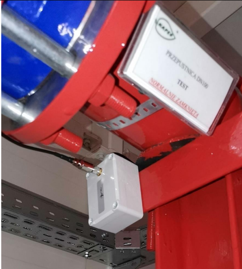
Kontrola ciśnienia w instalacji ppoż.
